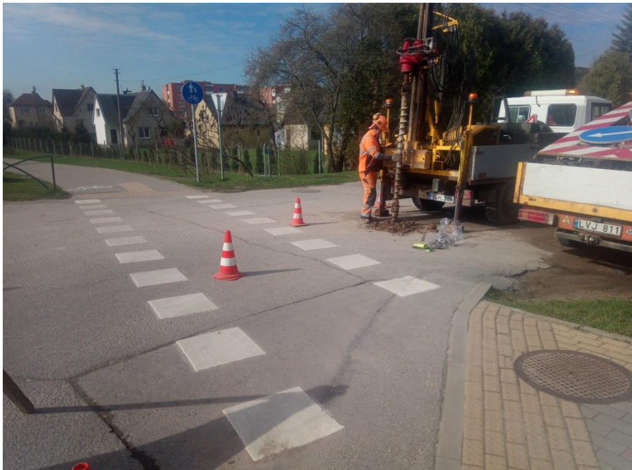
1 pav. Lauko darbai
